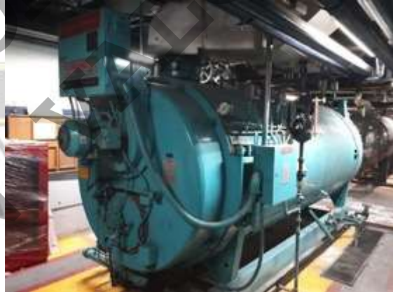
MANTENIMIENTO A CALDERA
