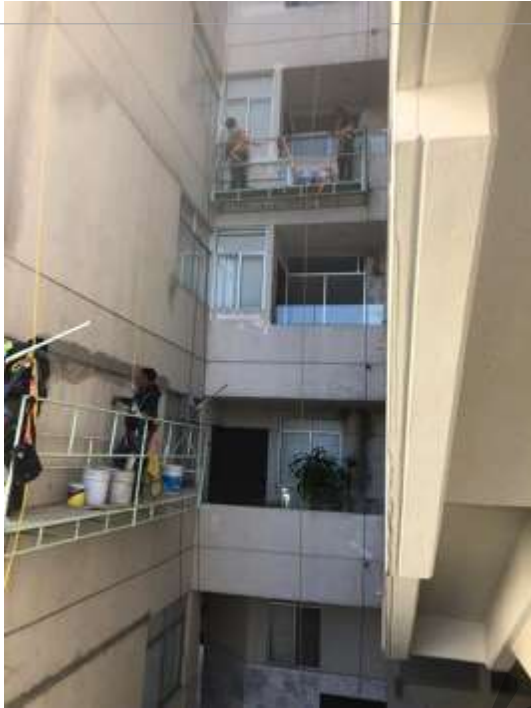
APLICACIÓN DE PINTURA
