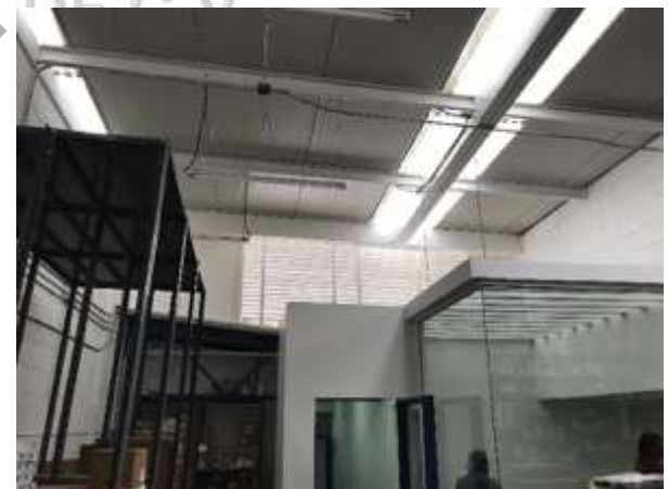
ALMACÉN LOGEN PORTALES
