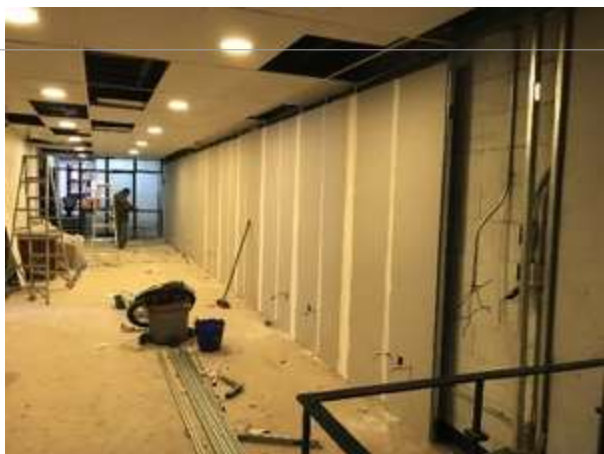
ALMACÉN LOGEN PORTALES
