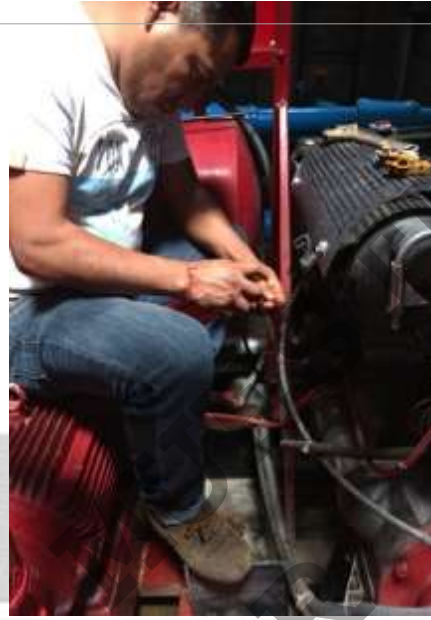
MANTENIMIENTO A LA RED CONTRAINCENDIOS
