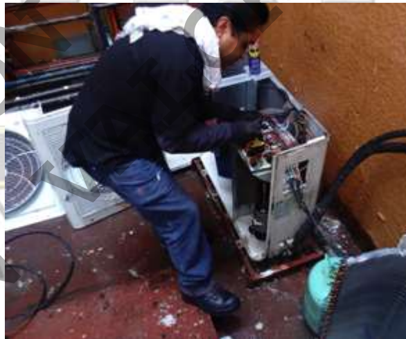
MANTENIMIENTO A SISTEMAS DE AIRE ACONDICIONADO
