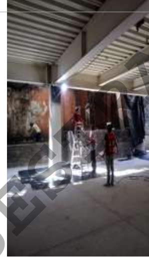
APLICACIÓN DE PINTURA FIRE CONTROL
