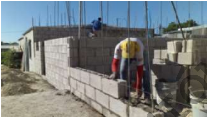
CONSTRUCCIÓN DE VIVIENDAS PARA EL PROGRAMA FICAPRO
