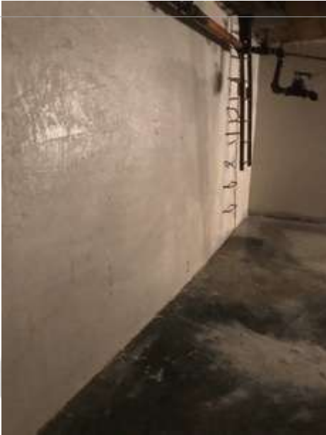
MANTENIMIENTO Y LAVADO DE CISTERNA
