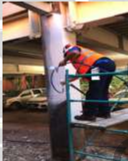
APLICACIÓN DE PINTURA FIRE CONTROL
