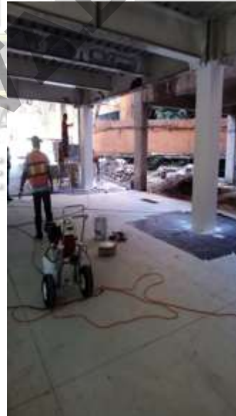
APLICACIÓN DE FIRE CONTROL
