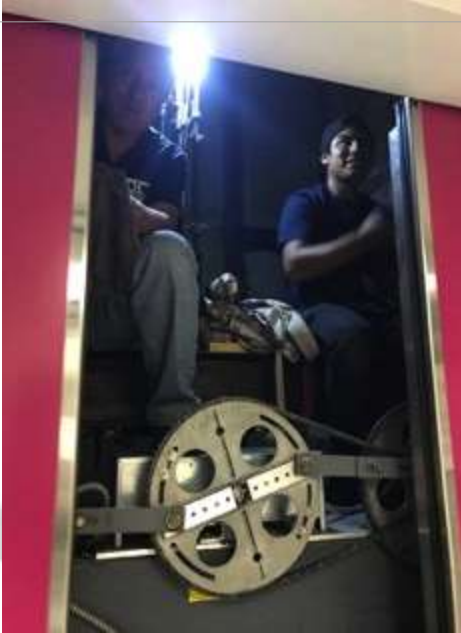
MANTENIMIENTO A SISTEMAS DE ELEVADORES
