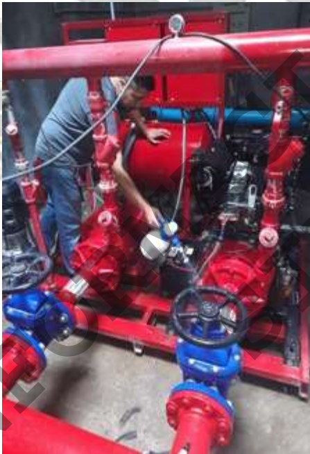
MANTENIMIENTO A LA RED CONTRAINCENDIOS
