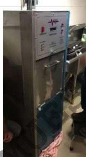
INSTALACIÓN DE EQUIPOS TIPO LAVA CÓMODOS
