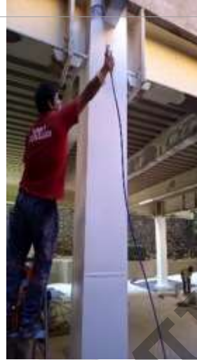
APLICACIÓN DE PINTURA FIRE CONTROL
