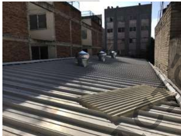
ALMACÉN LOGEN PORTALES
