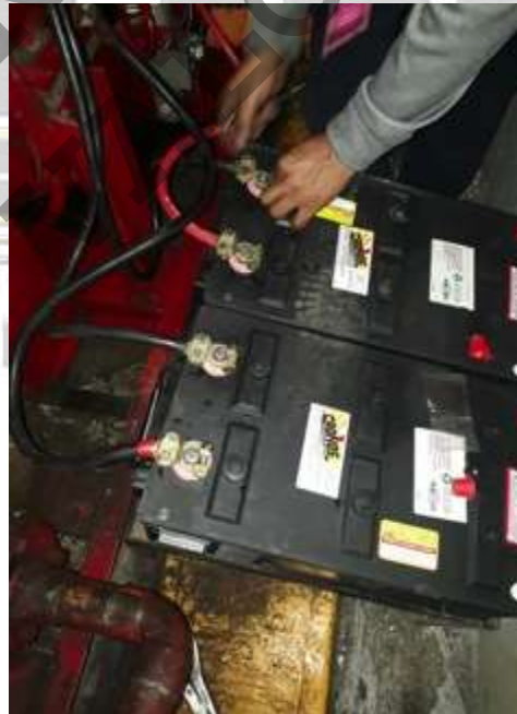
MANTENIMIENTO A LA RED CONTRAINCENDIOS
