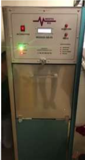
INSTALACIÓN DE EQUIPOS TIPO LAVA CÓMODOS
