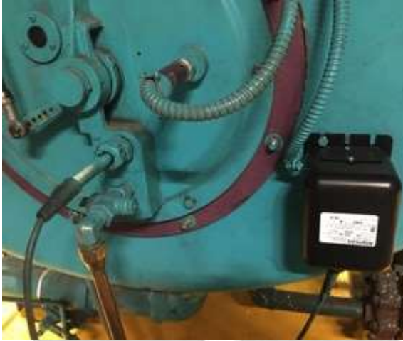
MANTENIMIENTO A CALDERA
