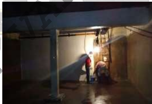
MANTENIMIENTO Y LAVADO DE CISTERNA
