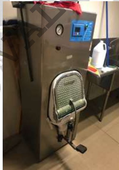
INSTALACIÓN DE EQUIPOS TIPO LAVA CÓMODOS
