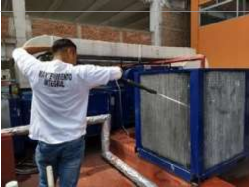
MANTENIMIENTO A SISTEMAS DE AIRE ACONDICIONADO
