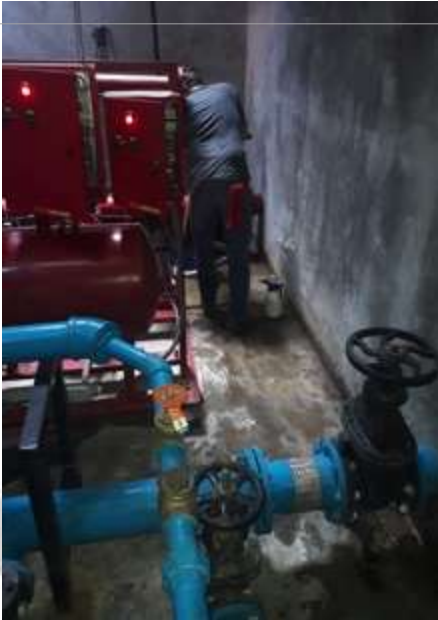
MANTENIMIENTO A LA RED CONTRAINCENDIOS
