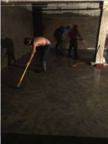
MANTENIMIENTO Y LAVADO DE CISTERNA
