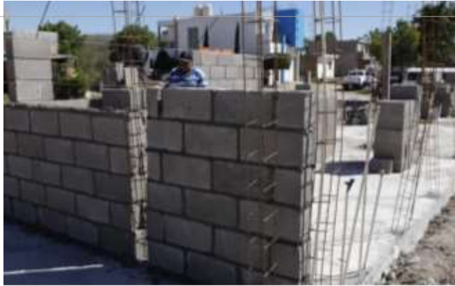
CONSTRUCCIÓN DE VIVIENDAS PARA EL PROGRAMA FICAPRO
