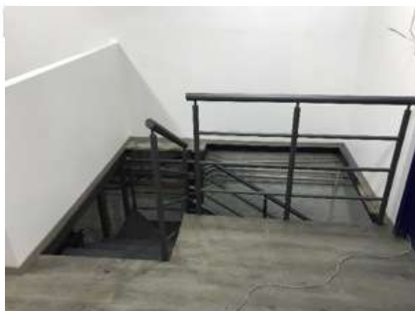
ALMACÉN LOGEN PORTALES
