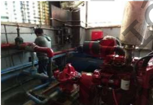
MANTENIMIENTO A LA RED CONTRAINCENDIOS
