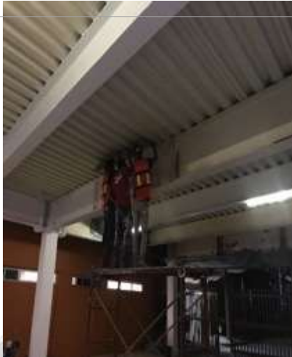
APLICACIÓN DE PINTURA FIRE CONTROL
