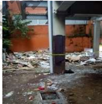
PISO DE CONCRETO PARA ESTACIONAMIENTO
