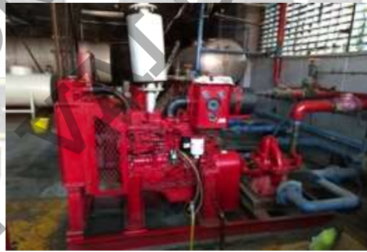
MANTENIMIENTO A LA RED CONTRAINCENDIOS
